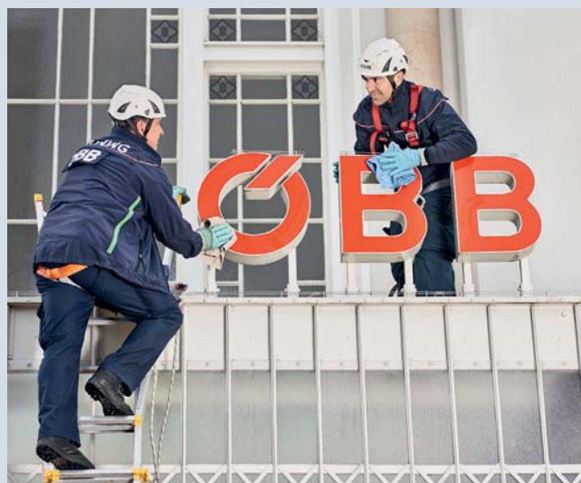
Reinigung an der Fassade des Hauptbahnhofs.
