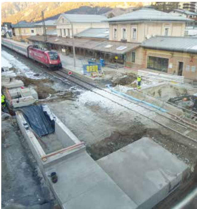
Baustelle Bahnhof Bad Gastein: Im Vordergrund ist der Rohbau der künftigen Unterführung zum Mittelbahnsteig zu erkennen, im Hintergrund steht ein IC-Zug zur Abfahrt nach Salzburg bereit.
