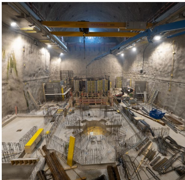
Kaverne Kraftwerk Tauernmoos
